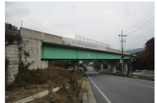
천안교(양양) 측면 전경
