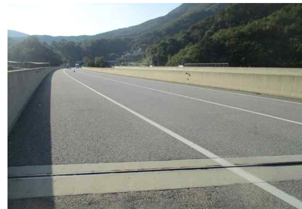
천안교(양양) 상부 전경
